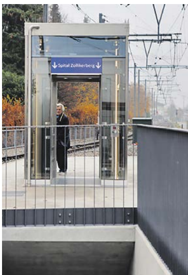
Die neue Unterführung samt Lift erleichtert nun den Zugang zu den Zügen an der Haltestelle Spital Zollikerberg. (Bild: zvg)
